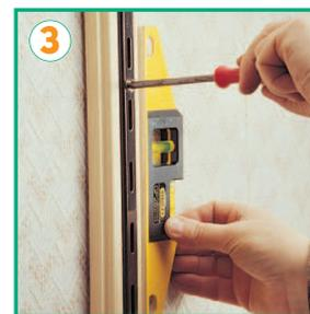
**3:** fissata la prima vite, si ricorre alla livella per avere la giusta verticalità, verificando anche ruotandola di 180°.
