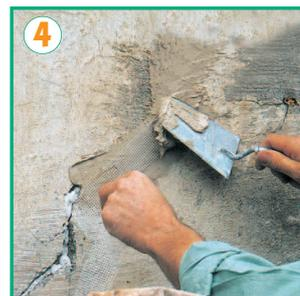
**4:** in alternativa si può usare l'intonaco, armato con reticella antiritiro.
