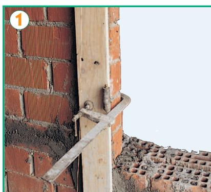
1: per realizzare uno spigolo dobbiamo, inizialmente, fissare una tavola a piombo che sporga di circa 2 cm oltre i mattoni. L'incavo che si forma va riempito con la malta.
