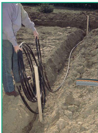
**S**ul fondo dello scavo, prima di srotolare il tubo, si stende uno strato di sabbia che ha la funzione di costituire un letto morbido e senza contrasti per il tubo. Il livello per gli irrigatori si trova appoggiando una tavola di legno sui lati dello scavo.
