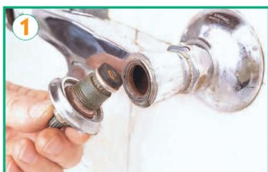
**1:** quando un rubinetto gocciola bisogna svitare il meccanismo di regolazione del flusso e sostituire la guarnizione.
