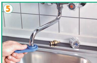
**5:** a volte il rompigetto presente sull'erogatore si intasa di calcare. Per allentarlo usiamo l'apposita chiavetta.
