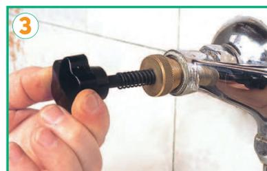
**3:** inseriamo la fresa nella sede del meccanismo e ruotandola spianiamo la bocca contro cui poggia la guarnizione.
