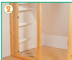
**2:** dotiamo il vano interno di mensole e fissiamo il telaio alle pareti con tasselli.
