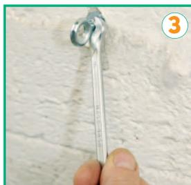
**4:** orientare correttamente l'elemento di sostegno.
