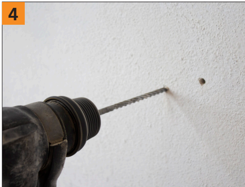
Forare il muro nei punti precedentemente segnati.
