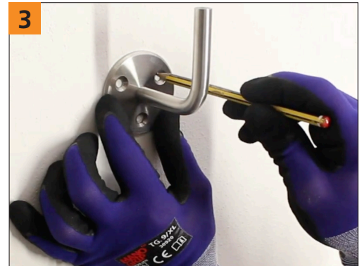
Segnare la posizione esatta i fori da eseguire.
