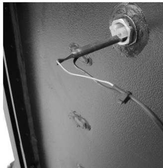
**Sonda di temperatura acqua:** se la temperatura dell'acqua si avvicina alla temperatura di blocco (100°C) la sonda impone di interrompere l'alimentazione del pellet.
