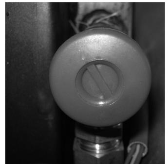
**Valvola di sicurezza:** questa valvola interviene per prevenire una sovrappressione dell'impianto idraulico. Se la pressione della termostufa o dell'impianto supera i 2,5 bar essa scarica l'acqua dal circuito.
