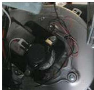
**Sonda temperatura fumi:** questa termocoppia rileva la temperatura dei fumi mantenendo il funzionamento oppure arrestando la caldaia quando la temperatura dei fumi scende sotto il valore preimpostato.
