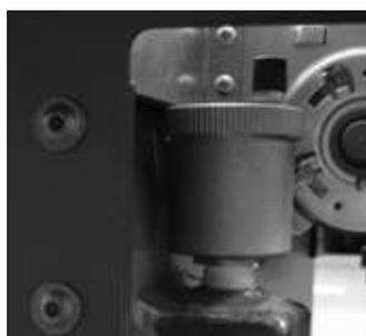
**Valvola di sfiato automatica:** questa valvola elimina l'aria all'interno della caldaia e dell'impianto di riscaldamento.
