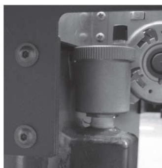
**Valvola di sfiato automatica:** questa valvola elimina l'aria all'interno dell'Inserto Camino e dell'impianto di riscaldamento.
