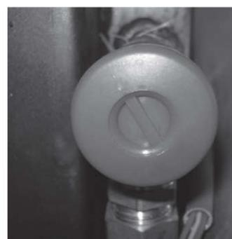
**Valvola di sicurezza:** questa valvola interviene per prevenire una sovrappressione dell'impianto idraulico. Se la pressione dell'Inserto Camino o dell'impianto supera i 2,5 bar essa scarica l'acqua dal circuito.
