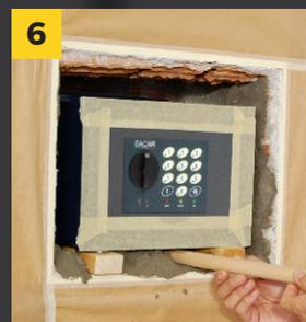
**7** Continuiamo così sino al totale riempimento, ma prima di completare lo strato più superficiale ricopriamo la facciata della cassaforte con un foglio di cartone. Solo in seguito livelliamo la superficie con nuova malta, rimuovendo l'eccesso e portando la quota pari al muro.
