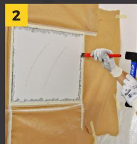
questa manovra impedisce la scheggiatura dell'intonaco. Al nastro fissiamo un telo di nylon e alcuni pezzi di carta a ulteriore protezione del muro.
