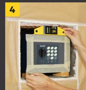
saforte distribuiamo uno strato di malta sul fondo e sulle pareti. Inseriamo la cassaforte nella cavità appoggiandola su tacchi di legno in modo che rimanga centrata nello spazio e, soprattutto, perfettamente livellata. Per rendere difficile la rimozione ai malintenzionati, circondiamo la cassaforte con rete elettrosaldata o applichiamo spezzoni di tondino di ferro.
