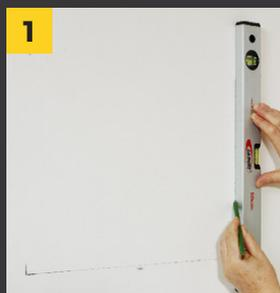
**1** Con le misure di ingombro tracciamo sul muro le linee di contorno della sagoma della cassaforte cui aggiungiamo 5-10 cm per lato, un margine necessario per l'aggiunta della malta. Manteniamo la perfetta orizzontalità e perpendicolarità utilizzando una livella.
