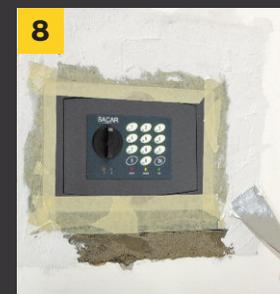
la parte di muro in cui siamo intervenuti, andando a raccordare perfettamente la zona appena riempita con il vecchio intonaco. È fondamentale in questa fase lasciare aperta la porta della cassaforte per alcuni giorni, in modo che non si formi condensa a causa dell'evaporazione dell'acqua nel cemento. Al termine procediamo con la tinteggiatura della zona.
