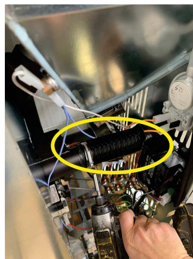
Fig. 51 - Collegare tubo flessibile
