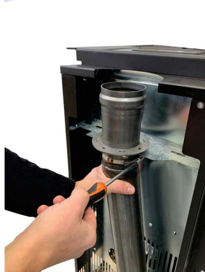
Fig. 42 - Bloccare con fascetta
