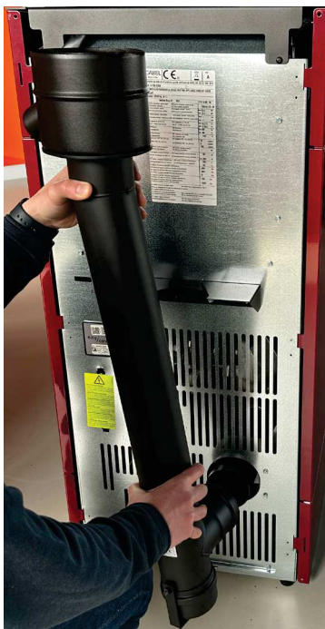
Fig. 56 - Kit scarico fumi superiore con concentrico
