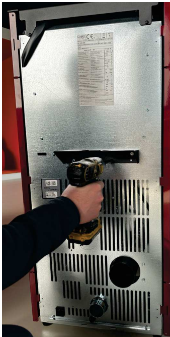
Fig. 54 - Avvitare il supporto
