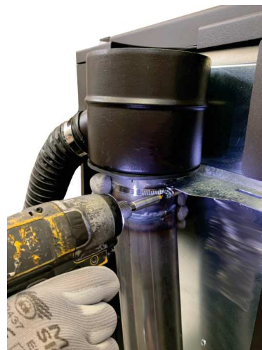
Fig. 48 - Bloccare con fascetta
