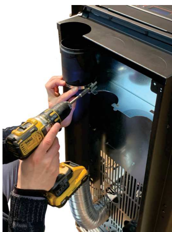
Fig. 69 - Bloccare tubo d.80 mm
