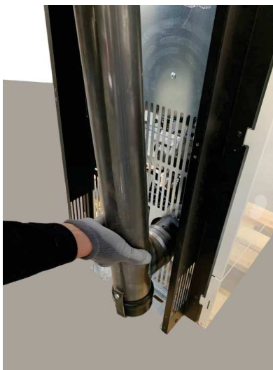
Fig. 41 - Innestare tubo d.80 mm
