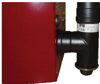
Fig. 79 - Pulizia canale da fumo
