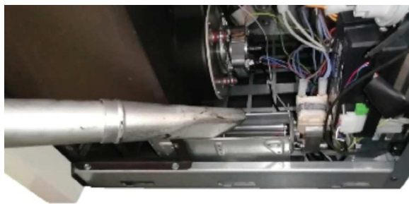
Fig. 87 - Pulizia ventilatore ambiente
