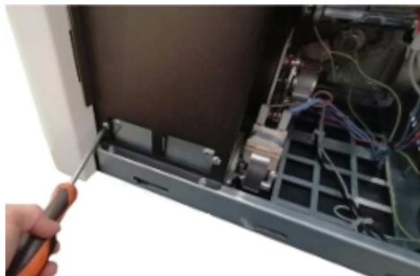
Fig. 101 - Pulizia ventilatore ambiente
