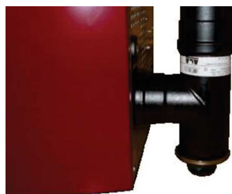
Fig. 89 - Pulizia canale da fumo
