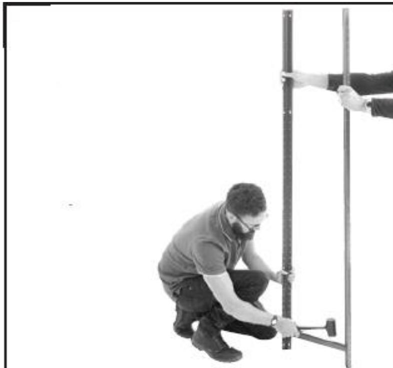
**5^ PASSAGGIO:** Continuare ad aggiungere le travi laterali (B) ai montati (A) alle altezze desiderate dei ripiani per creare il telaio laterale.
