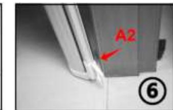
Avvitare le parti A1 e A2 al muro installare il tubo di metallo su di esse (immagine ⑥ e ⑦)
