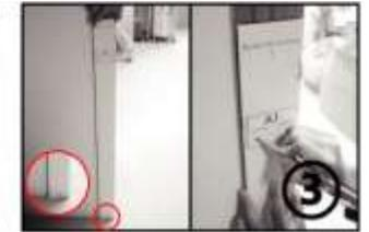
Identificare tutti i pezzi prima del montaggio. Munirsi di matita e cacciavite. Posizionare le linee guida SX nel luogo desiderato e accertarsi che il cartone sia appoggiato al pavimento. Segnare con la penna i punti in cui avvitare A1 e A2
