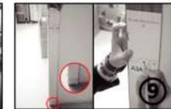
Inserisci il tappo A5 nell'attacco A1. Posizionare le linee guida DX nel luogo desiderato e accertarsi che il cartone sia appoggiato al pavimento. Assicurarsi che A4 si trovi ad un'altezza di 28mm dal pavimento e segnare i punti in cui avvitare A3 e A4.
