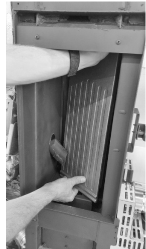
Fig. 68 - Rimuovere la schiena del focolare 2
