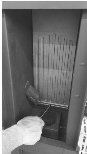
Fig. 67 - Rimuovere la schiena del focolare 1
