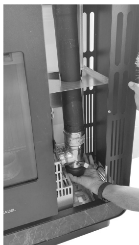
Fig. 65 - Pulizia canale da fumo
