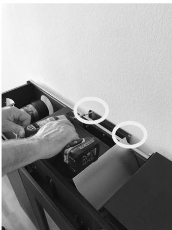
**Fig. 19 - Fissaggio al muro**
