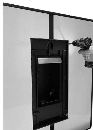
**Fig. 38 - Fissaggio rivestimento**
