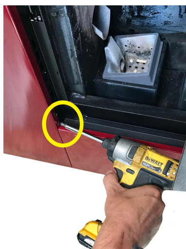
Fig. 50 - Rimozione viti 1
