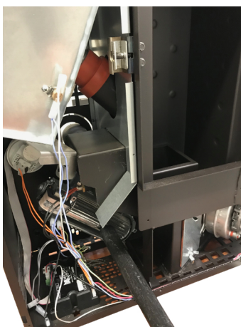
Fig. 93 - Pulizia ventilatore ambiente
