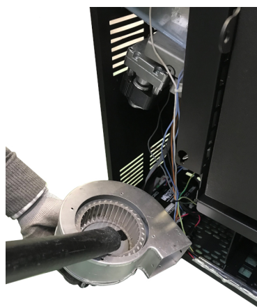
Fig. 95 - Pulizia ventilatore ambiente
