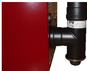
Fig. 67 - Pulizia canale da fumo
