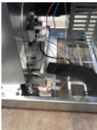
Fig. 77 - Pulizia ventilatore ambiente
