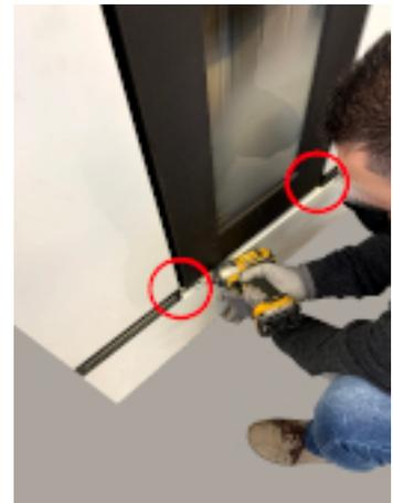
**Fig. 47 - Fissare pannello inferiore**
