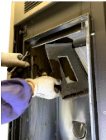
Fig. 120 - Rimuovere la testa del focolare 2
