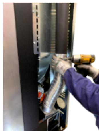
**Fig. 85 - Fissare i tubi**
