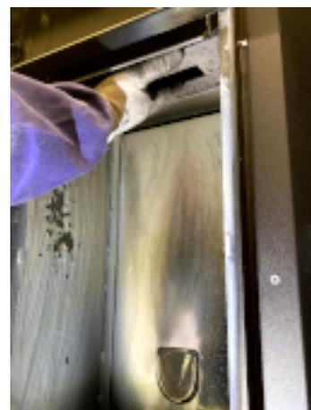
Fig. 119 - Rimuovere la testa del focolare 1
