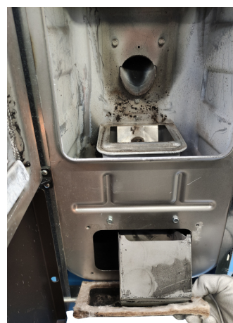
Fig. 74 - Rimuovere tappo ispezione
