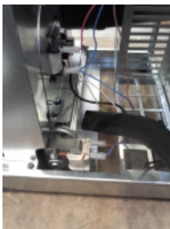
Fig. 79 - Pulizia ventilatore ambiente
