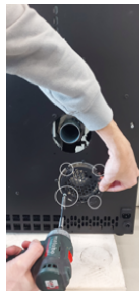
Fig. 98 - Pulizia ventilatore ambiente 3
