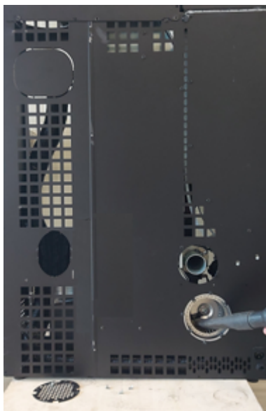
Fig. 97 - Pulizia ventilatore ambiente 2
