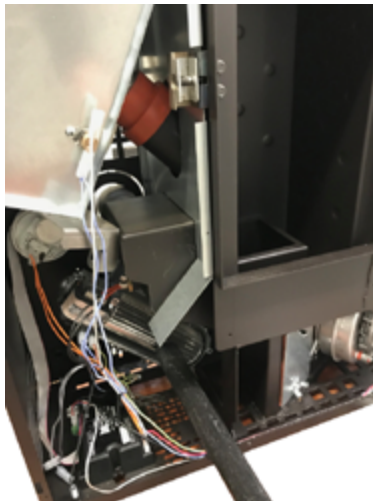
Fig. 93 - Pulizia ventilatore ambiente
