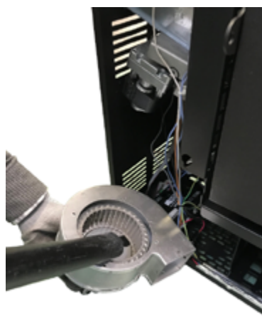
Fig. 95 - Pulizia ventilatore ambiente
