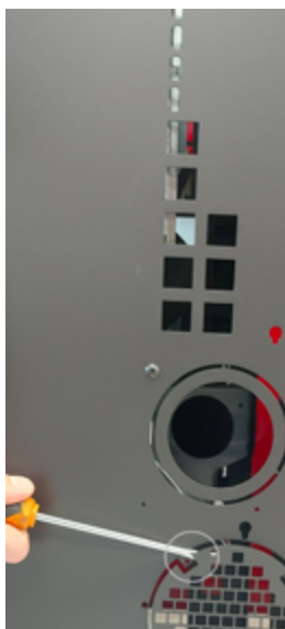
Fig. 96 - Pulizia ventilatore ambiente 1
