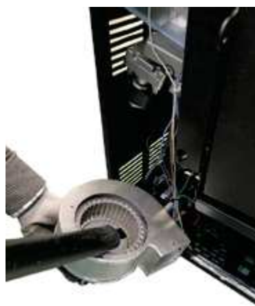
Fig. 95 - Pulizia ventilatore ambiente
