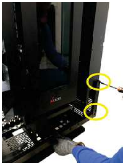
Fig. 41 - Fissaggio staffa inferiore
