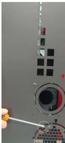
Fig. 96 - Pulizia ventilatore ambiente 1
