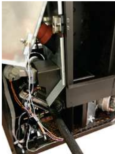
Fig. 93 - Pulizia ventilatore ambiente
