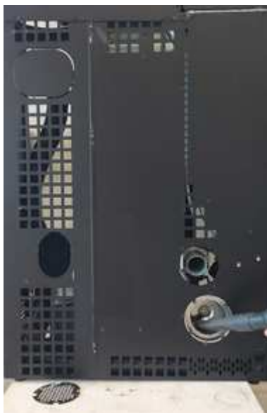
Fig. 97 - Pulizia ventilatore ambiente 2
