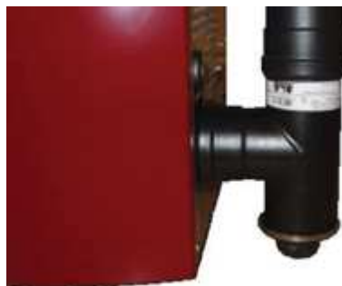
Fig. 87 - Pulizia canale da fumo
