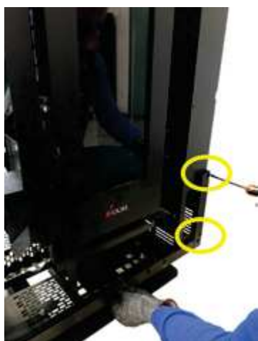
Fig. 34 - Fissaggio staffa inferiore
