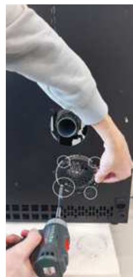
Fig. 98 - Pulizia ventilatore ambiente 3
