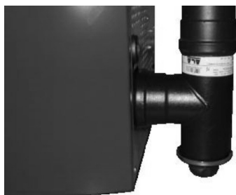
Fig. 66 - Pulizia canale da fumo
